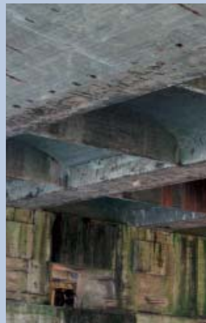
Onderkant van de plofsluis met een holle bodem van ongewapend beton
