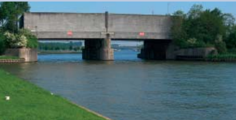
Plofsluis vanaf de grond gezien
